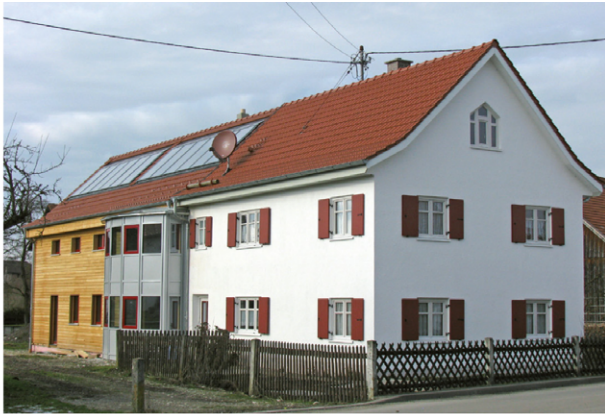
◆ 2012 Tussenhausen, Landkreis Unterallgäu Sanierung Bauernhof mit Ersatzbau für Stadel
